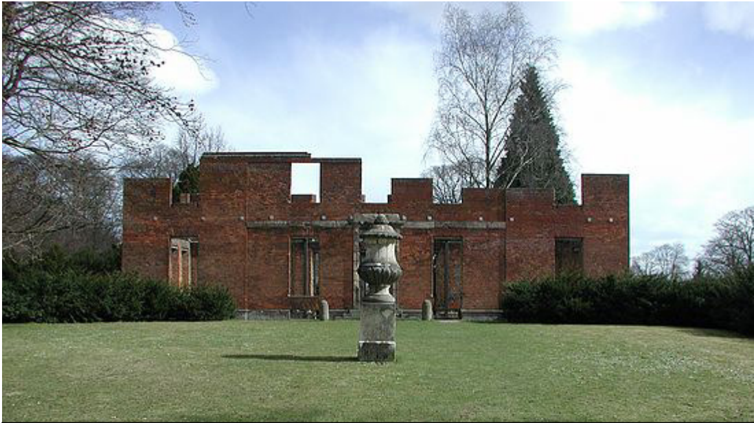
Vi mødes på parkeringspladsen foran Aldershvile Slotsruin
